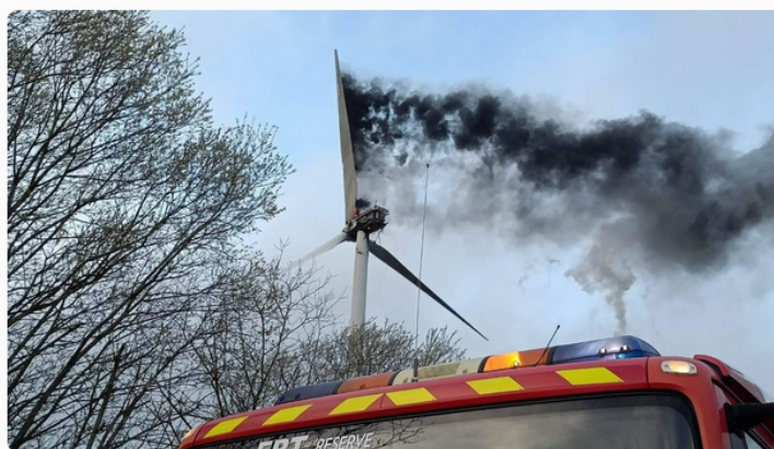
Le moteur de l'éolienne en feu à Froidfond - Pompiers
